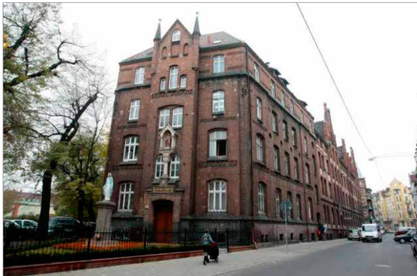
Dom sióstr elżbietanek i szpital przy ul. Łąkowej – widok współczesny
